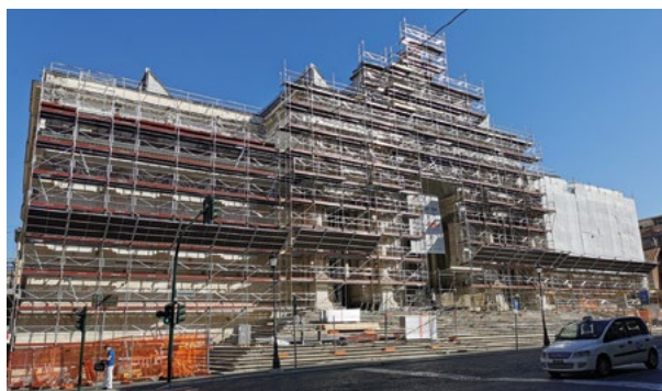
Ponteggio di facciata per lavori di restauro di un edificio storico
