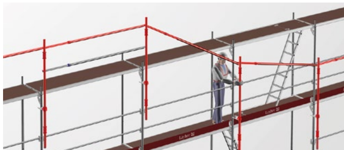
Parapetto provvisorio di montaggio per la protezione laterale del livello successivo.
