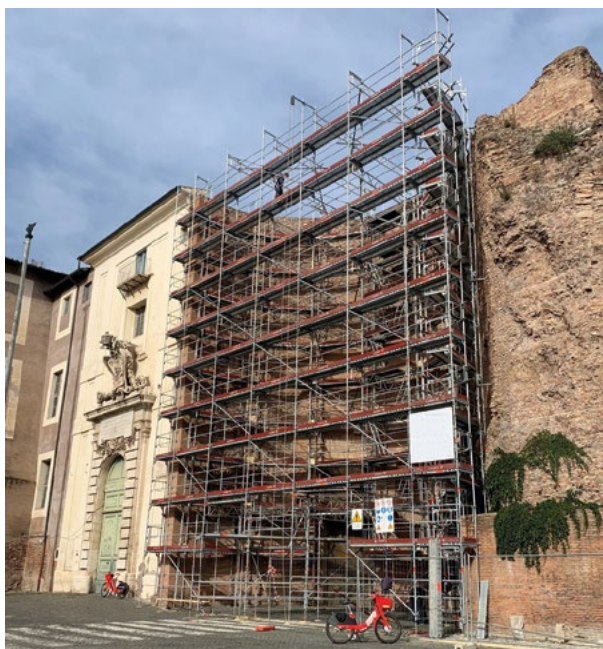
Ponteggio di facciata e circolare per lavori di restauro in un complesso monumentale
