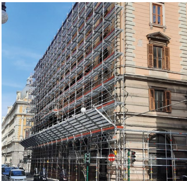
Ponteggio di facciata al servizio di un palazzo storico
