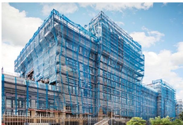
Ponteggi di facciata al servizio di un ampio edificio industriale
