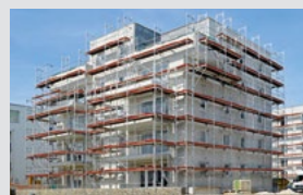
Impalcato Stalu – impalcato leggero in alluminio, dotato di robuste testate terminali in acciaio rivettate.
